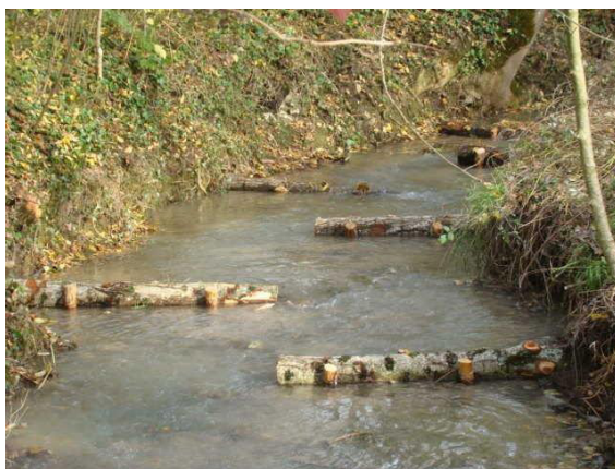
Diversification des écoulements par techniques de génie végétal
