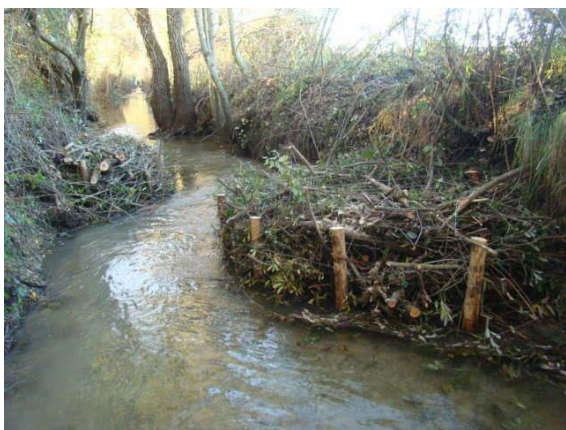
Diversification des écoulements par techniques de génie végétal
